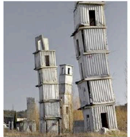
immeubles et tole rouillée - A. Kiefer
